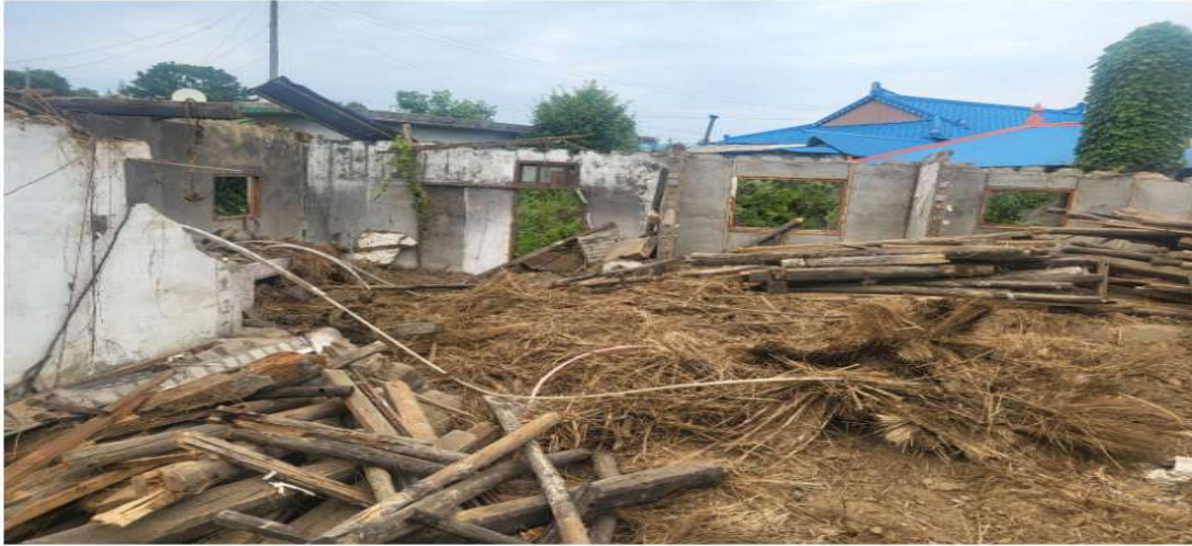
▲ 지붕 철거 후 내부 목재 처리
